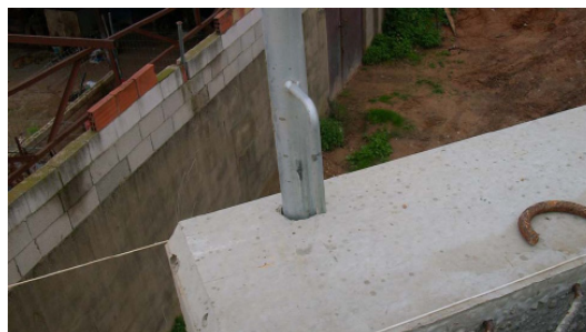
Foto 5.- Imposta previamente perforada.
