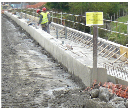
Foto 4.- Separación de los trabajadores del tráfico de maquinaria.
