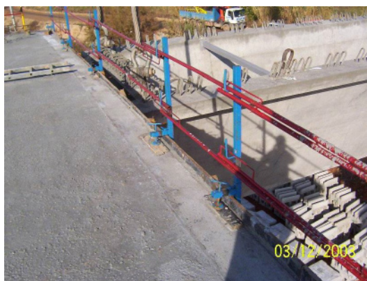
Foto 6.- Mal ejemplo. ¿Cómo se ha montado la barandilla?
