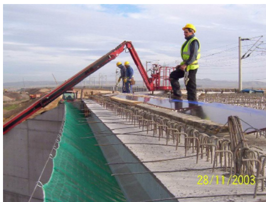
Foto 3.- Protección perimetral mediante redes.
